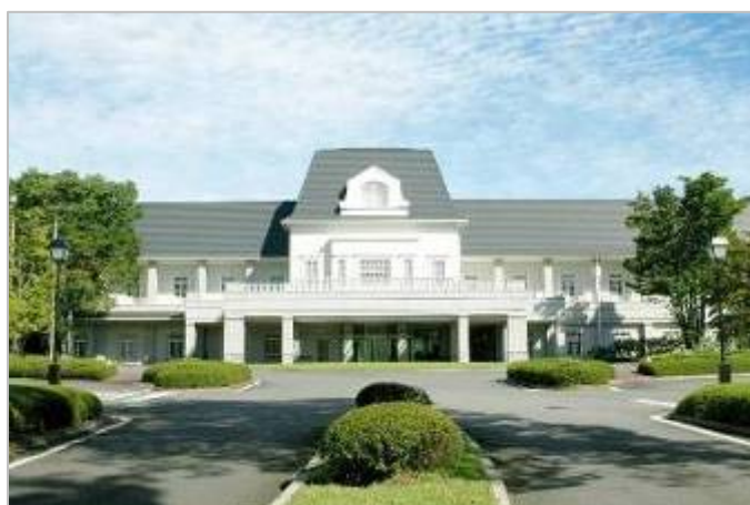
蓄熱システム式ヒートポンプ導入例： 富岡カントリークラブ クラブハウス
