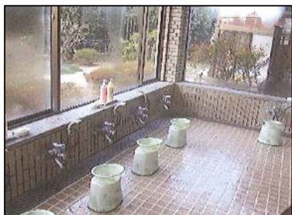
改修前の浴室
