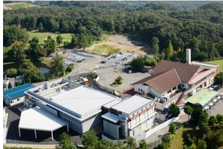
左:新築の“ロッカー・浴室棟”、右:解体前のクラブハウス
