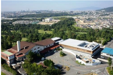
左:解体前のクラブハウス、右:新築の“ロッカー・浴室棟”
