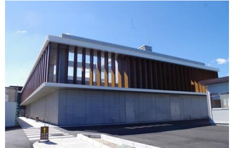
新築の“ロッカー・浴室棟”
