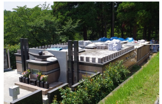
増設工事中の永代供養墓「いにしえ」
