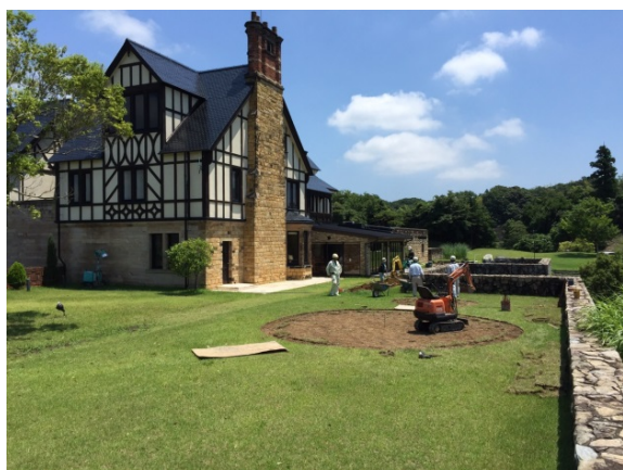
工事中のガーデンテラス
