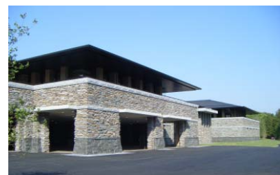
新クラブハウス 2 階部分 大きく出した庇(ひさし)
